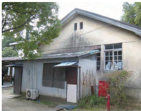
閉鎖になった有恒館
