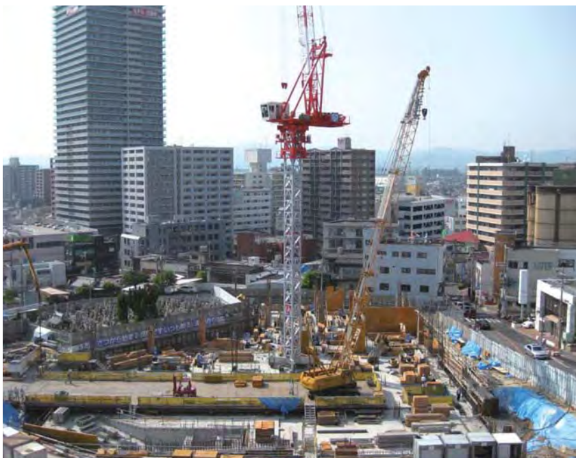
地上工事用のタワークレーンを組み立て中(4月30日撮影)
