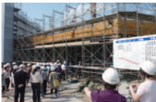
建築現場で説明を受ける参加者
