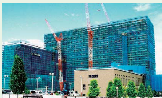
順調に工事が進む新学舎(手前が低層棟) 8月1日撮影
