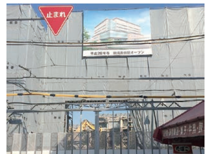
工事フェンスには、新滝井病院本館のパース図が掲示されています。
