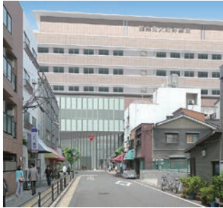
京阪電車滝井駅方面から見た様子
