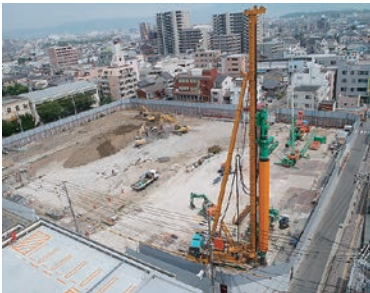
6月16日時点のリニューアル工事現場写真
