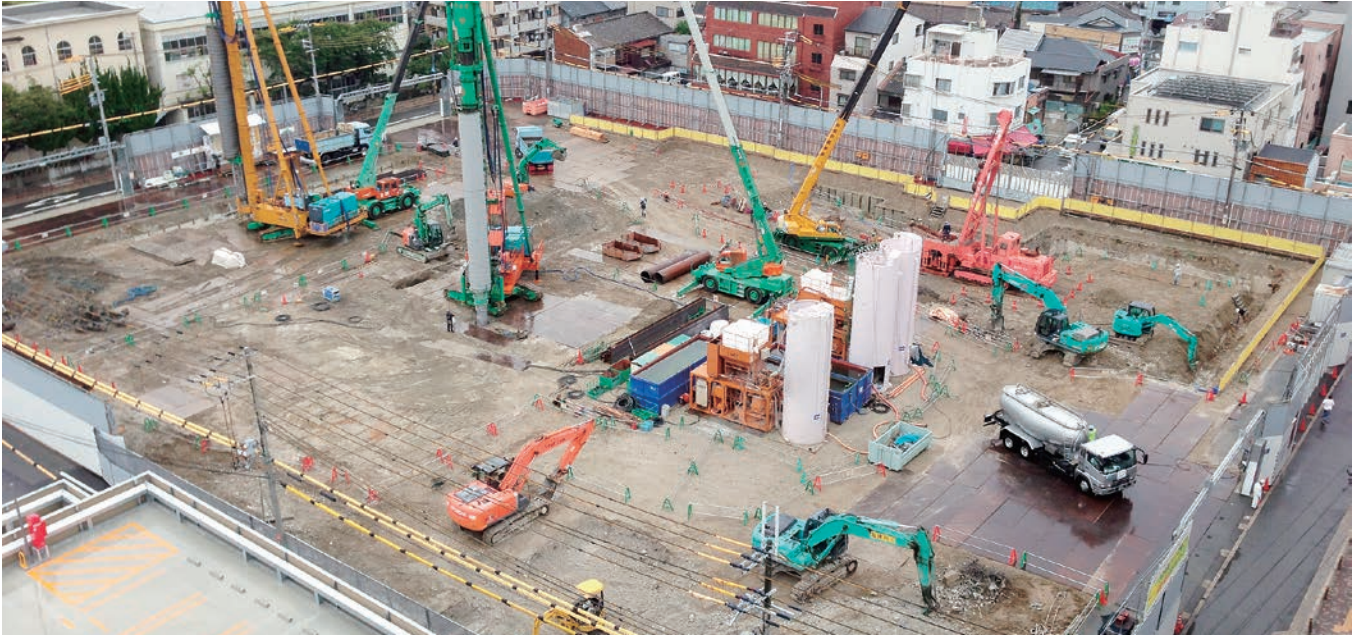
9月1日時点でのリニューアル工事現場写真
