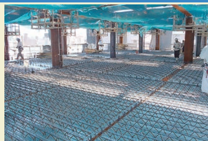
4階部分の床デッキを組み込み中
