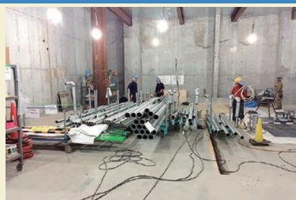
地下は配線工事の準備が進んでいます
