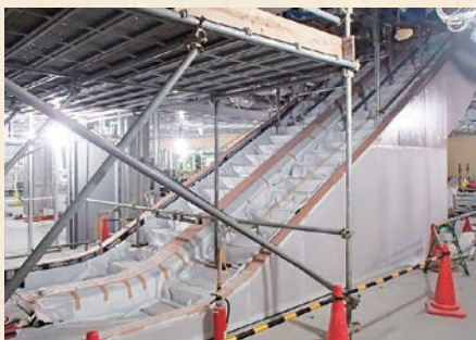
1階エスカレーターの設置
