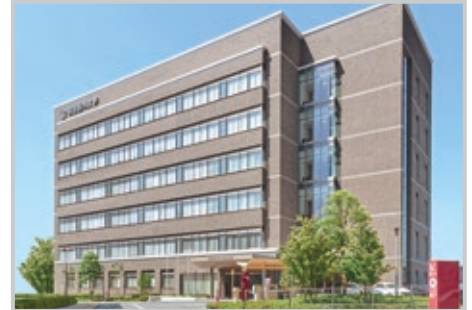
2月に竣工した看護学部棟外観
